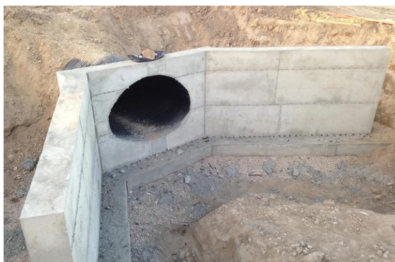
7 pav. Gelžbetoninės atraminės sienutės įrengimo pavyzdys ( https://muddinc.biz/work/retaining-walls/ )
