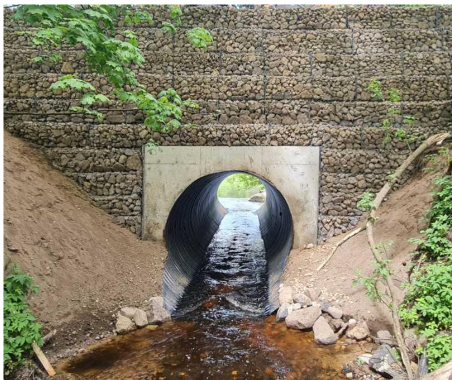
2 pav. Gabionų atraminės sienutės įrengimo pavyzdys (Lietuva)
