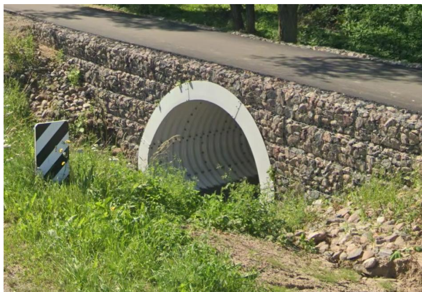
5 pav. Gabionų atraminės sienutės įrengimo pavyzdys (Lietuva)
