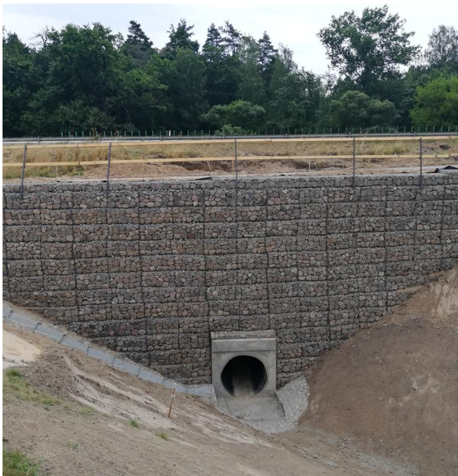
3 pav. Gabionų atraminės sienutės įrengimo pavyzdys (Lietuva)
