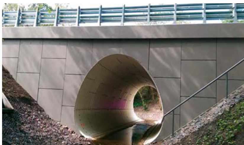
6 pav. Armuotos geosintetika atraminės sienutės įrengimo pavyzdys (Lenkija)
